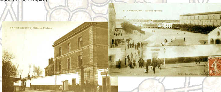
Caserne Proteau avant la première guerre mondiale : boulevard de la bretonnière
