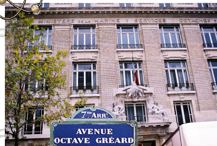
L'EAMEA est installée provisoirement dans quelques pièces d'un immeuble de la Marine situé tout près de la Tour Eiffel.
