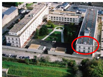
Vue aérienne de l'EAMEA (situation des locaux du GEA)
