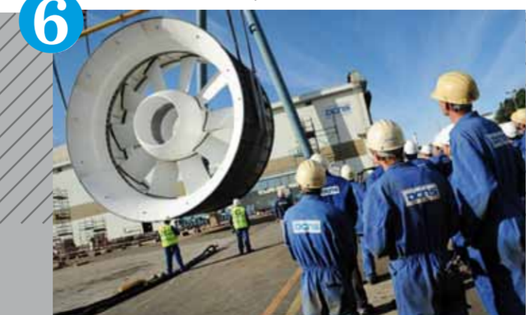
6 Mise à l'eau d'une hydrolienne (France)
