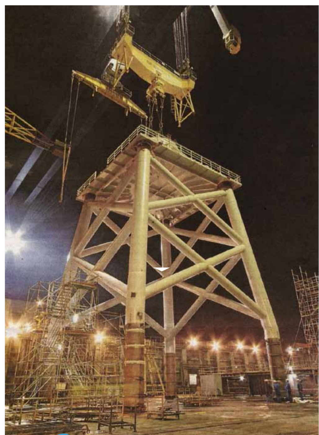
6 Structure support d'une éolienne off-shore 6 MW
